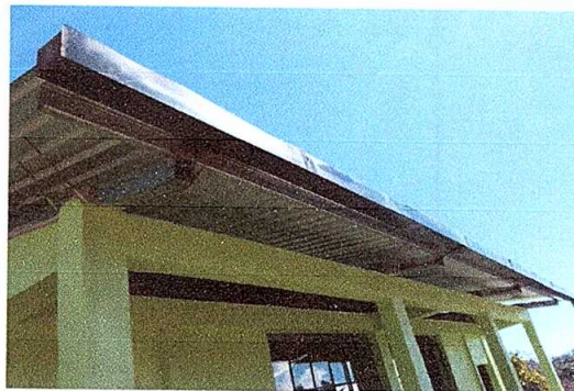
Foto 2: Sustitución de estructura de techo.
