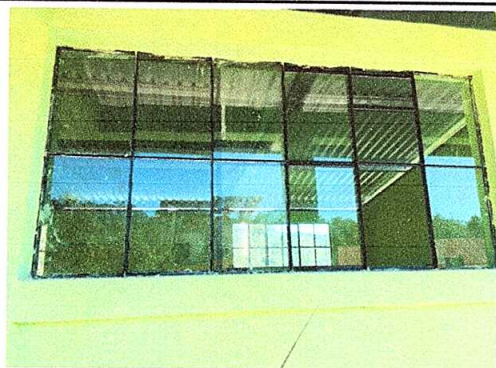
Foto 3: Sustitución de ventanas.
