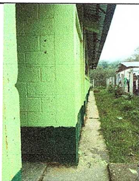
Foto 5: Pintura en muros exteriores e interiores.
