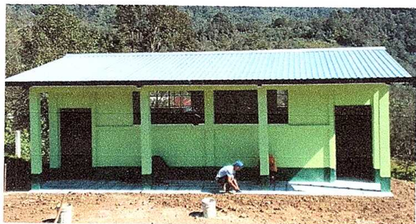
Foto 1: Sustitución de cubierta de lámina.
