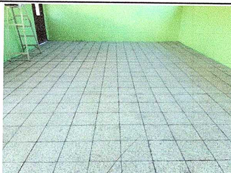
Foto 6: Sustitución de piso.
