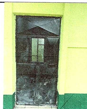
Foto 4: Sustitución de puertas.
