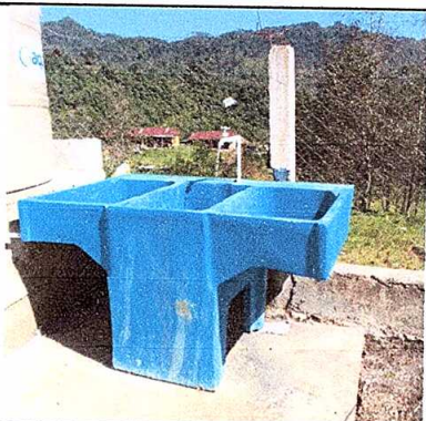
Foto 9: Sustitución de pila de cemento.
