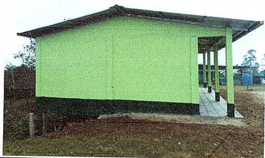
Foto 7: Sustitución de pared de madera por block.
