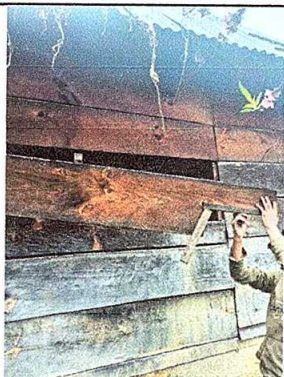
Foto 7: Sustitución de pared de madera por block.
