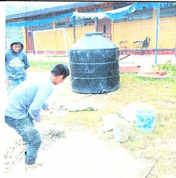
Foto 8: Sustitución de depósito de agua.
