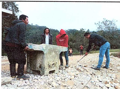
Foto 9: Sustitución de pila de cemento.
