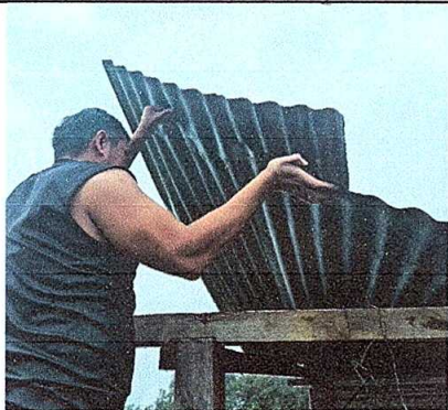
Foto 1: Sustitución de cubierta de lámina.
