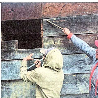
Foto 3: Sustitución de ventanas.
