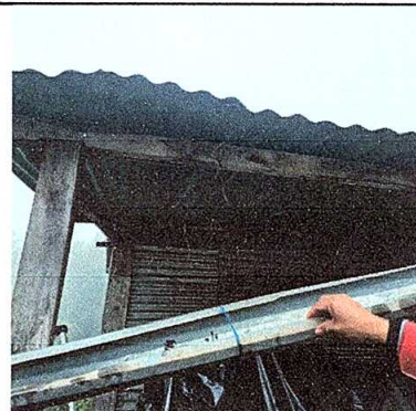
Foto 2: Sustitución de estructura de techo.
