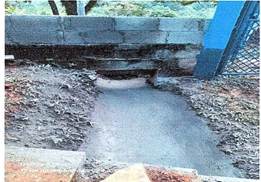
8 Reparación de muro perimetral de blocks
