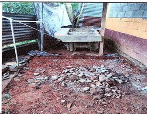
6 Sustitución de pila de cemento de dos lavadero
