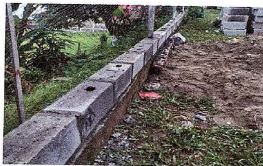
8 Reparación de muro perimetral de blocks.
