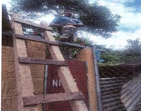
1: CUBIERTA DE LAMINA. Sustitución de láminas acanaladas simples por láminas troqueladas de baños
