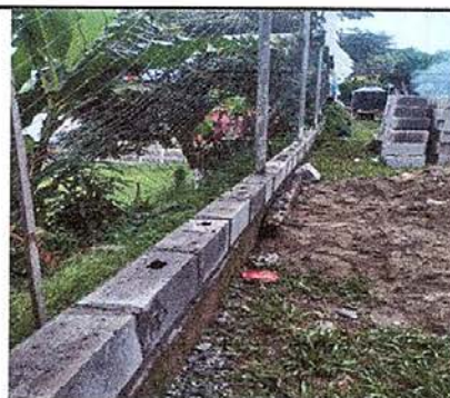
4 Reparación de muro perimetral de block.
