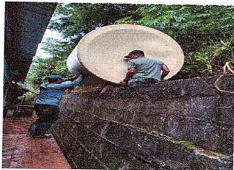
7 Sustitución de depósito de agua 2500 litros
