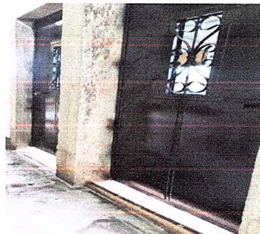
Foto No. 2 sustitución de puertas
