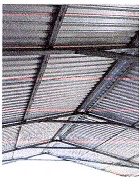
Foto No. 3 Estructura de techo
