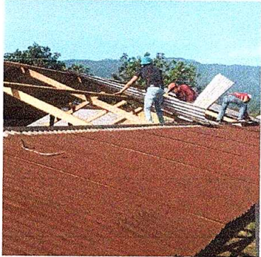
Foto No. 1 sustitución de techo
