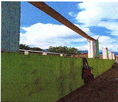
Foto No.5 Mejoramiento de pared
