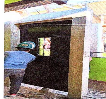
Foto No. 2 sustitución de puertas
