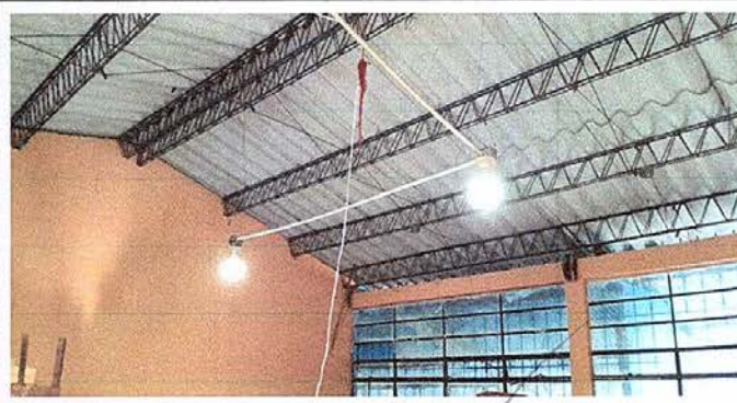
FOTO No. 8 Sustitución de lámparas tipo LED
