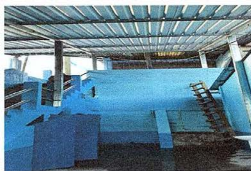
FOTO No. 2 Sustrucción de soporte de madera por metal
