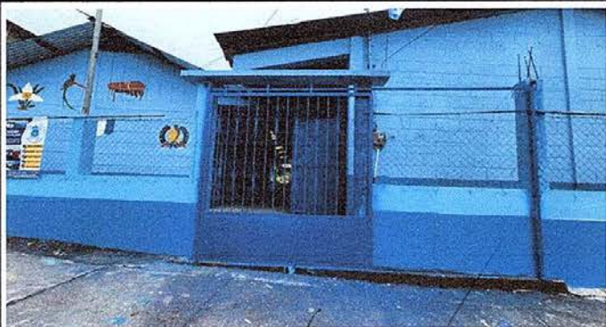
FOTO No. 7 Mantenimiento al portón de metal
