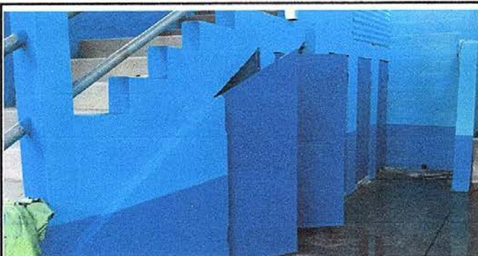
FOTO No. 3 Sustrucción de puertas en servicios sanitarios
