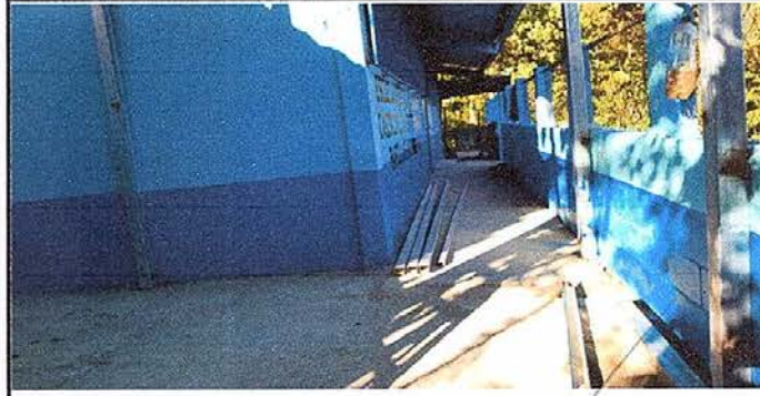
FOTO No. 6 Pintura en muros exteriores e interiores
