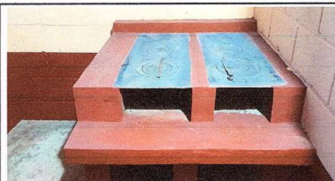
FOTO No. 9 Sustitución de plancha de 3 hornillas
