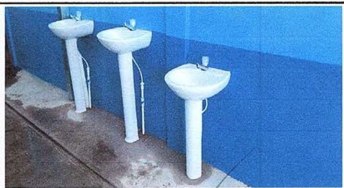
Foto No. 10 Sustitución de Lavamanos
