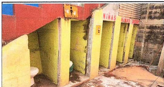
FOTO No. 3 Sustitución de puertas en servicios sanitarios
