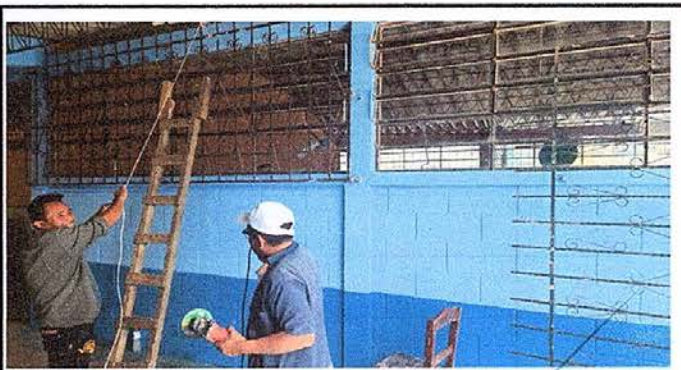
FOTO No. 4 Mantenimiento y cambio de balcones de metal
