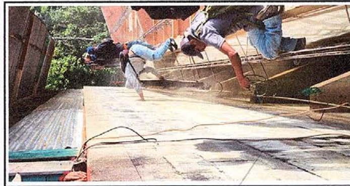
FOTO No. 5 Sustitución de Canal
