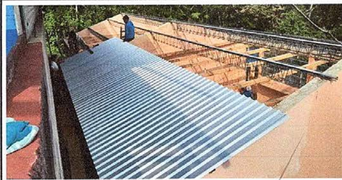
FOTO No. 9 Instalación de lamina troquelada aluzinc
