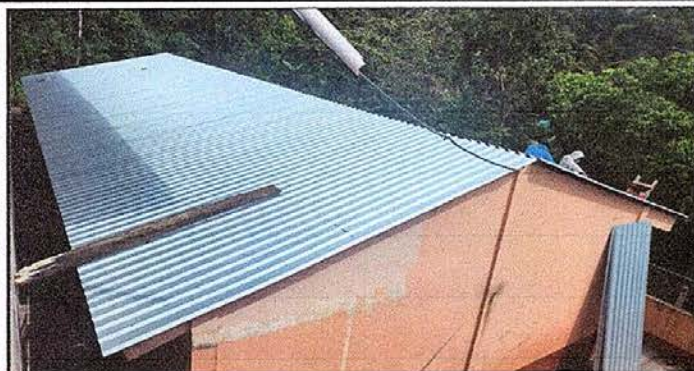
FOTO No. 1 Sustitución de techo
