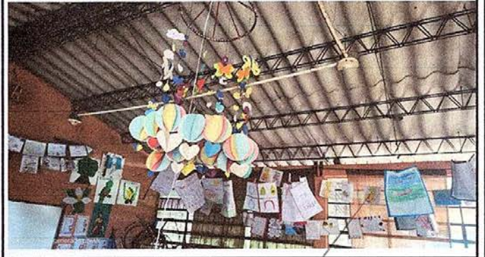
FOTO No. 8 Sustitución de lámparas tipo LED
