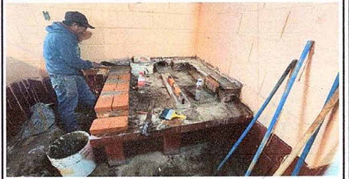
FOTO No. 10 Sustitución de planchas de 3 hornillas
