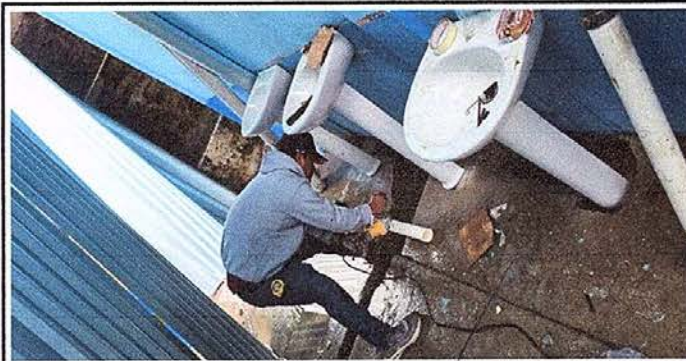
FOTO No. 11 Sustitución de lavamanos
