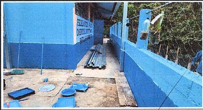
FOTO No. 6 Pintura en muros exteriores e interiores
