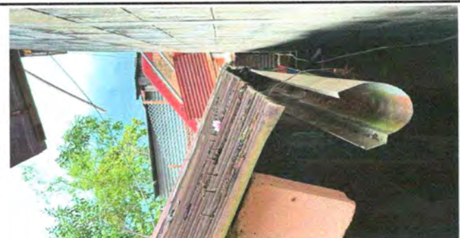
FOTO No. 5 Sustitución de Canal
