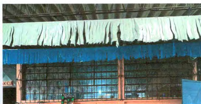
FOTO No. 4 Mantenimiento y cambio de balcones de metal
