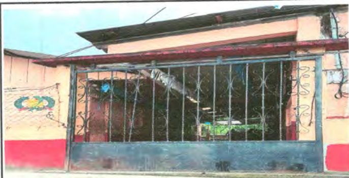
FOTO No. 7 Mantenimiento al portón de metal
