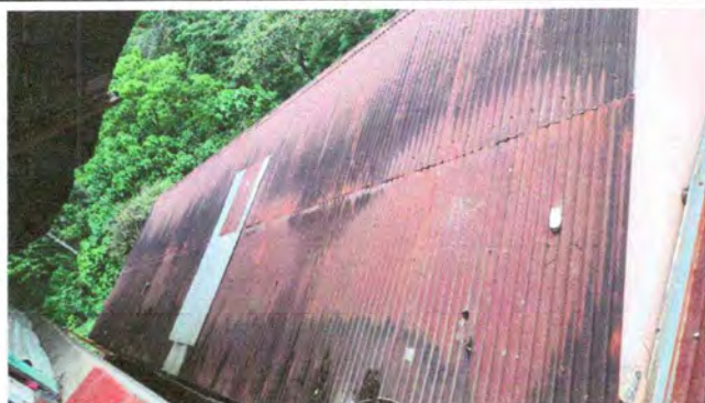
FOTO No. 1 Sustitución de techo
