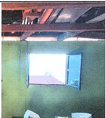
Foto 3: Sustitución de ventanas.
