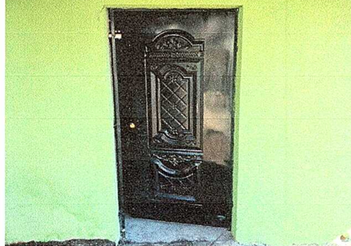
Foto 2: Sustitución de puerta de metal.
