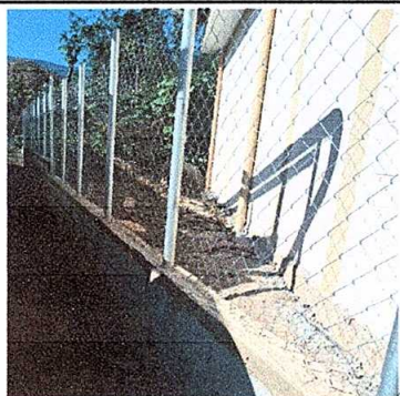
Foto 5: Sustitución de muro perimetral.
