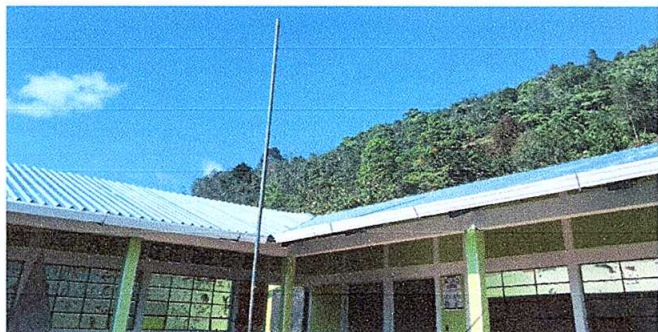
Foto 1: Sustitución de cubierta de lámina.
