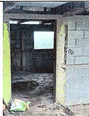
Foto 2: Sustitución de puerta de metal.
