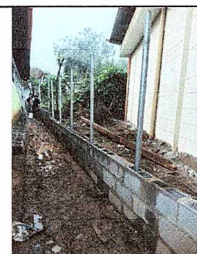
Foto 5: Sustitución de muro perimetral.
