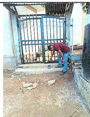
Foto 4: Mantenimiento a portones.
