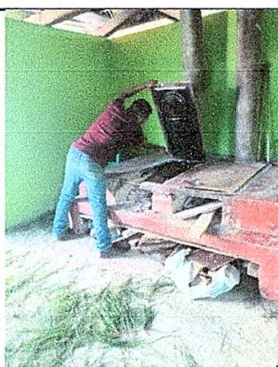
Foto 6: Reparación de cocina.
