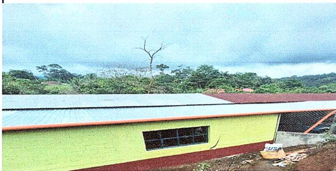
Foto 3: CUBIERTA DE LAMINA Y TECHO
