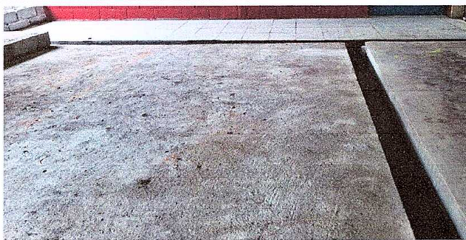
Foto 5: PISO DE LOSA
