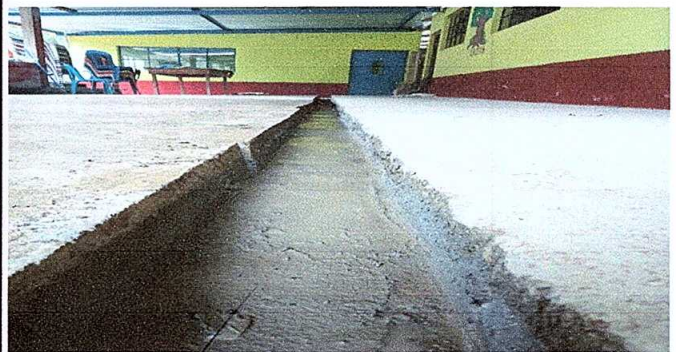
Foto 4: PINTURA Y CUNETA
