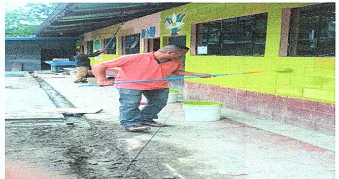
Foto 4: PINTURA Y CUNETA
