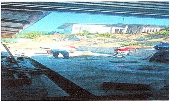
Foto 5: PISO DE LOSA
