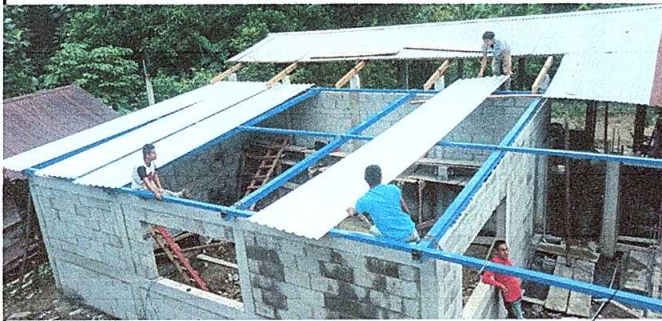
Foto 3: CUBIERTA DE LAMINA Y ESTRUCTURA DE SOPORTE
