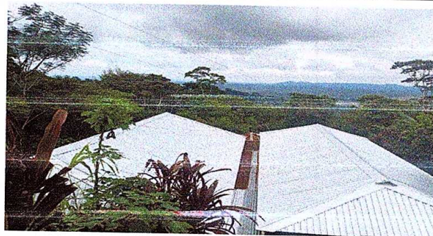
Foto 2: Sustitucion de lamina, por lamina troqueladaaluzinc calibre 26 16, 14, 12, 10 y 6 PIES
