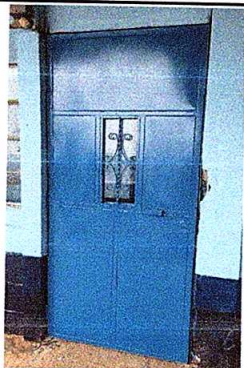
Foto1: SUSTITUCION DE PUERTAS
