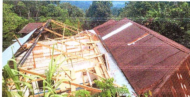
Foto 2: Sustitucion de lamina, por lamina troqueladaaluzinc calibre 26 16, 14, 12, 10 y 6 PIES
