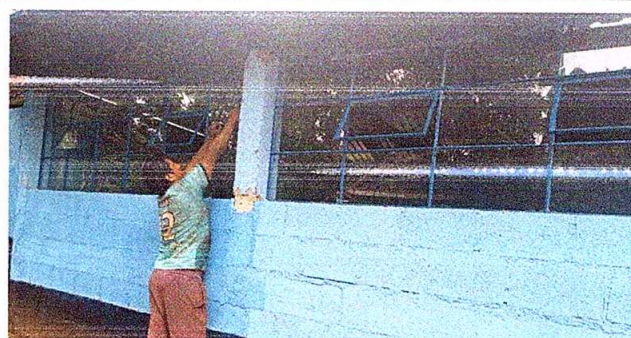
Foto 4: Sustitucion de estructuras de metal de ventanas
