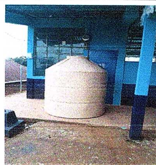
Foto 6: Sustitución de deposito de almacenamiento de agua
