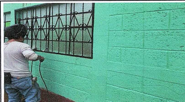
Foto 4: mantenimiento de ventanas
