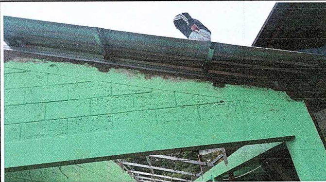
Foto 2: sustitucion de laminas por laminas troqueladas
