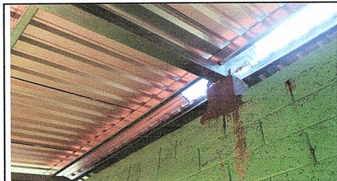
Foto: 3 sustitucion de reglas por costaneras
