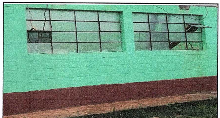
Foto 4: mantenimiento de ventanas
