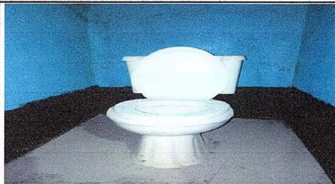
Foto 7: sustitución de accesorios inodoro (tubo de abasto), sustitución de inodoro y sustitución de llave de paso.
