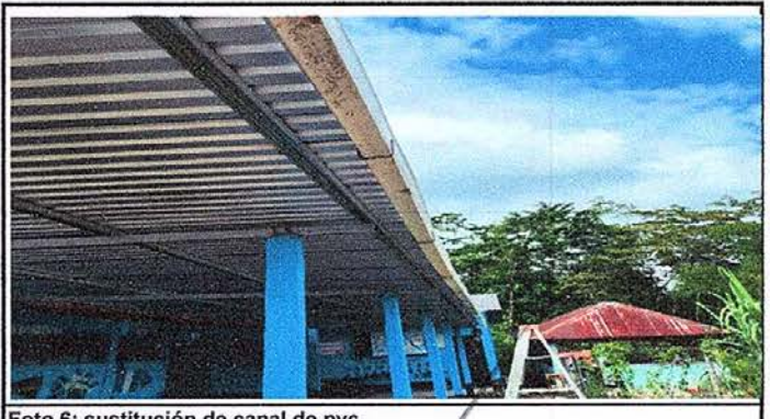
Foto 6: sustitución de canal de pvc.
