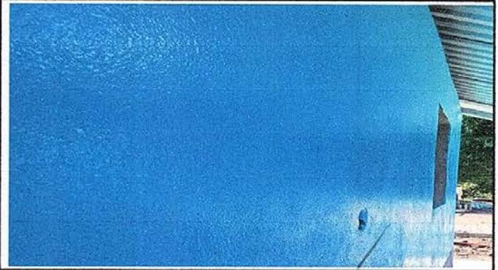
Foto 2: Pinturas en muros interiores y exteriores.
