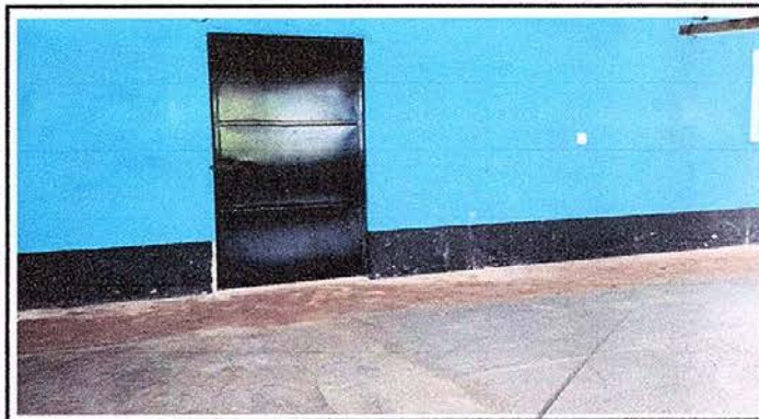
Foto 3: sustitución de puerta de madera a metal.
