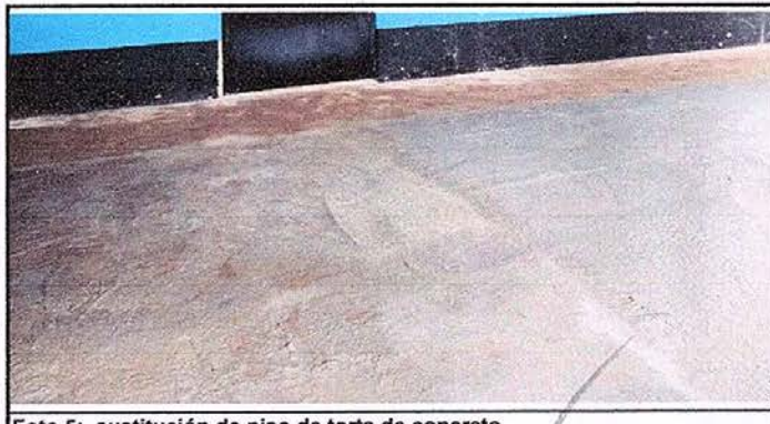
Foto 5: sustitución de piso de torta de concreto.
