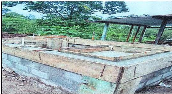
Foto 9: sustitución de pila de cemento de dos lavaderos.
