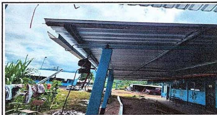
Foto 6: sustitución de canal de pvc.
