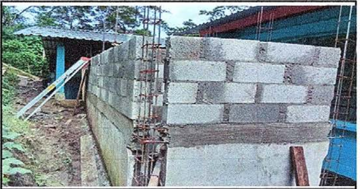
Foto 12: sustitución de tablas y láminas por block en baños.
