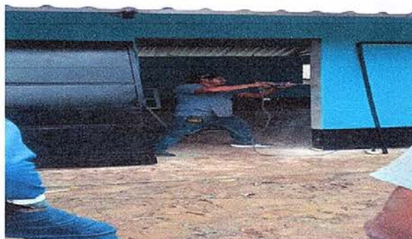
Foto 3: sustitución de puerta de madera a metal.
