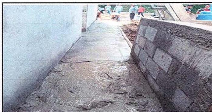
Foto 5: sustitución de piso de torta de concreto.
