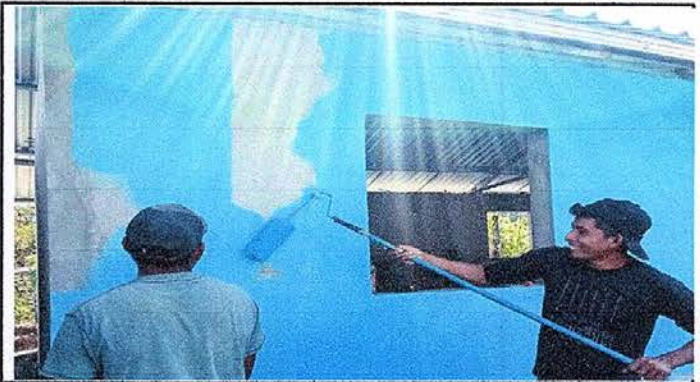
Foto 2: Pinturas en muros interiores y exteriores.
