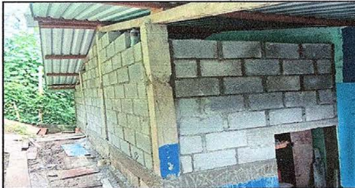
Foto 11: sustitución de tablas, por block en bodega.
