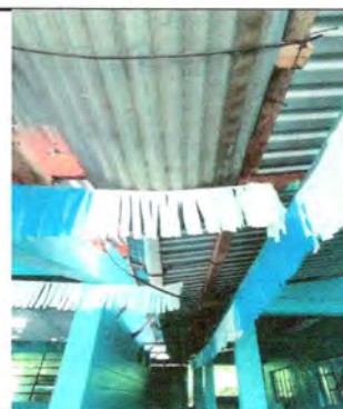
Foto 6: Sustitución de canal de pvc
