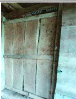
Foto 3: Sustitución de puerta de madera a metal
