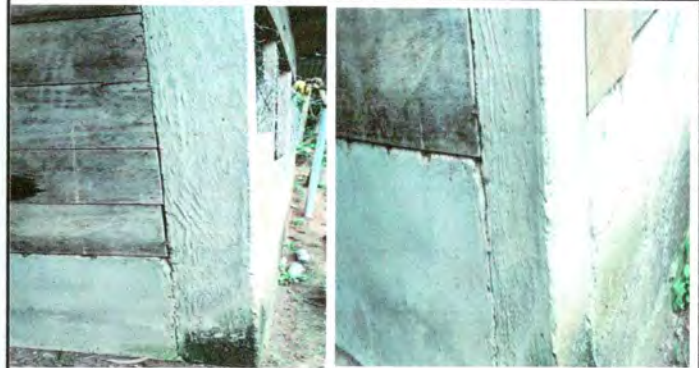
Foto 10: Sustitución de tablas, por block en cocina
