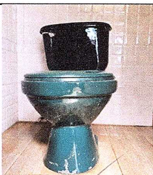
Foto 5: SUSTITUCIÓN DE INODORO
