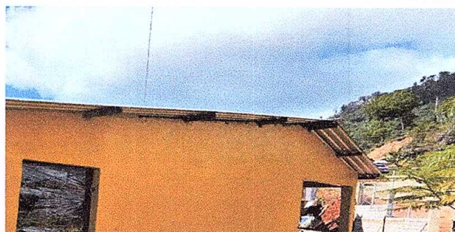
Foto 2: MANTENIMIENTO DE ESTRUCTURA DE SOPORTE DE MADERA POR METAL
