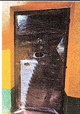
Foto 3: SUSTITUCIÓN DE PUERTAS DE METAL
