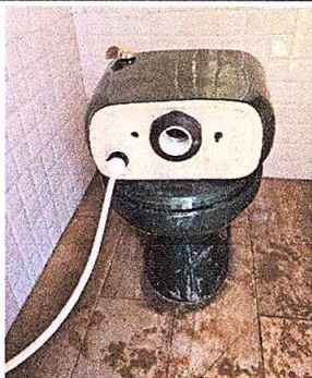
Foto 5: SUSTITUCIÓN DE INODORO
