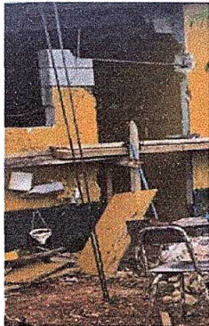
Foto 3: SUSTITUCIÓN DE PUERTAS DE METAL
