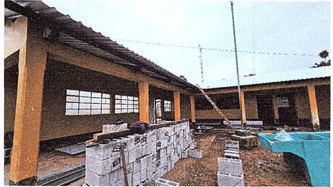
Foto 2: MANTENIMIENTO DE ESTRUCTURA DE SOPORTE DE MADERA POR METAL
