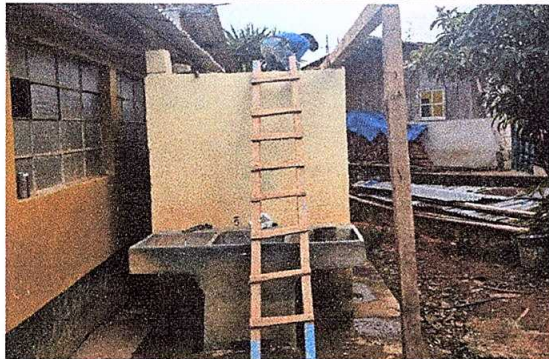
Foto1: SUSTITUCIÓN DE PILA DE CEMENTO DE 2 LAVADEROS
