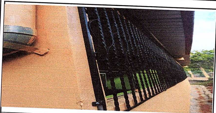
Foto 5: Sustitucion de balcones de madera por metal
