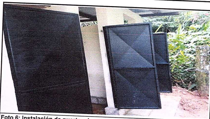
Foto 6: Instalación de puertas de metal en baños
