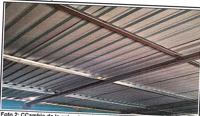
Foto 2: Cambio de la estructura de madera que se encuentra en deterioro total.
