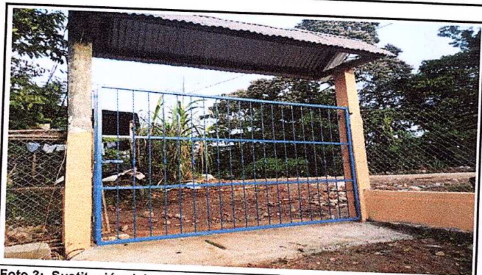
Foto 3: Sustitución del porton principal del centro educativo por deterioro total de 2 metros de altura por 3.20 metros de ancho.
