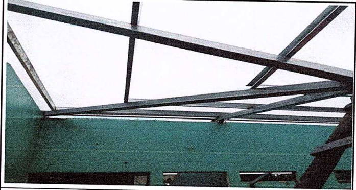
Foto 2: Cambio de la estructura de madera que se encuentra en deterioro total.
