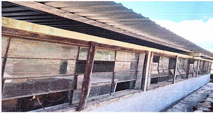
Foto1: Sustitución de balcones de madera por metal
