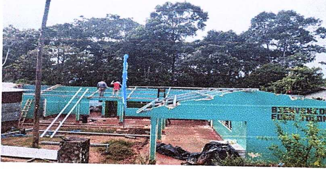
Foto1: Techo escolar. Cambio de la estructura del techo por desgaste en su totalidad.
