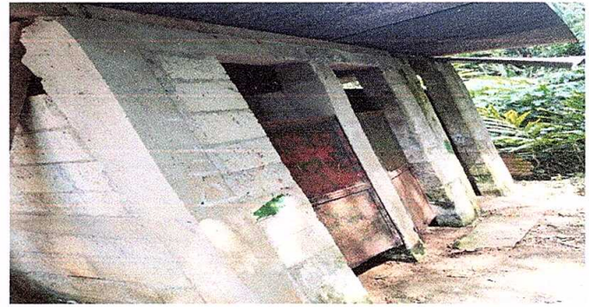
Foto 2: Instalación de puertas de metal en baños
