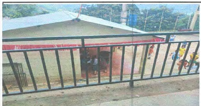
Foto 5 las nuevas barrandas
