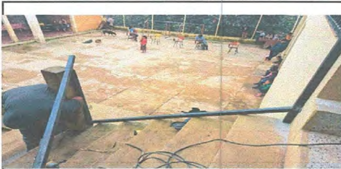
Foto 5 Instalando las barrandas
