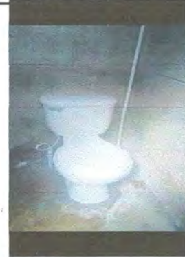
Foto N 2 Instalando los sanitarios
