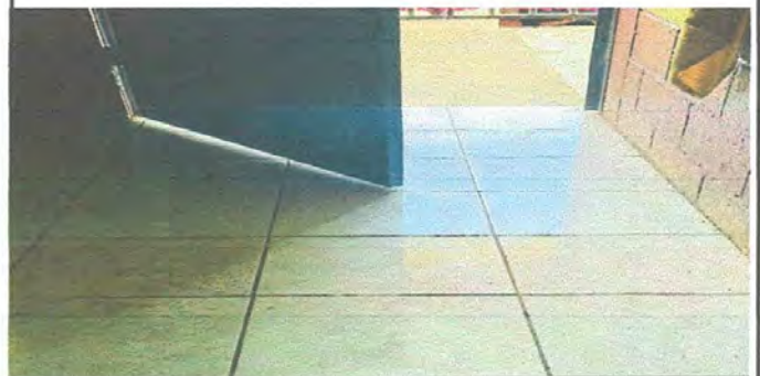
Foto 4 arreglando las puertas
