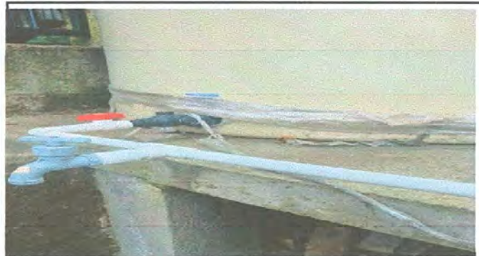
Foto 6 instalando los Tinacos
