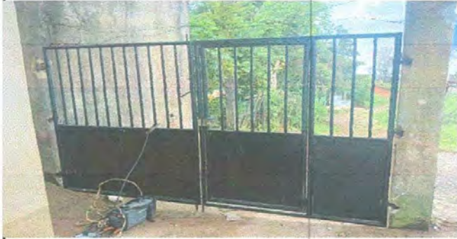
Foto N. 1 Instalando los portones
