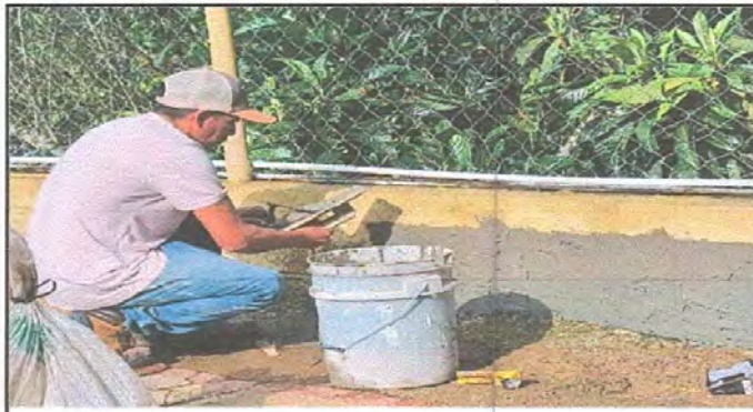
Foto 9 arreglando el muro
