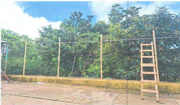
Foto 3 Instalando la maya
