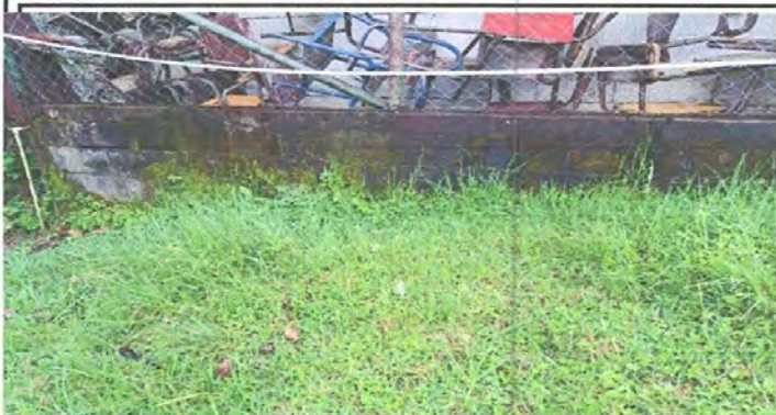
Foto No. 9 Reparación del muro
