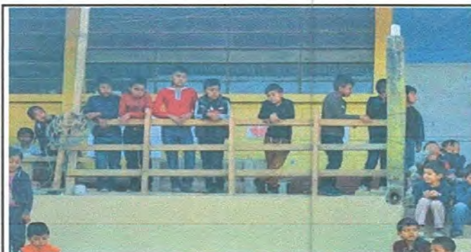
Foto 5: sustitución de baranda de madera por metal
