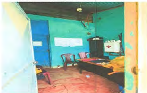
Foto No. 7 reparación de piso
