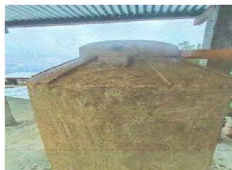
Foto 6: Sustitución de depósito de agua 1700 lt
