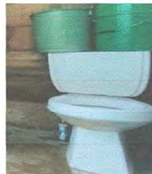
Foto 2: Sustitución de inodoros
