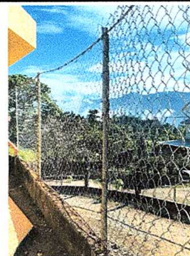
Foto 6: Reparación de muro perimetral.
