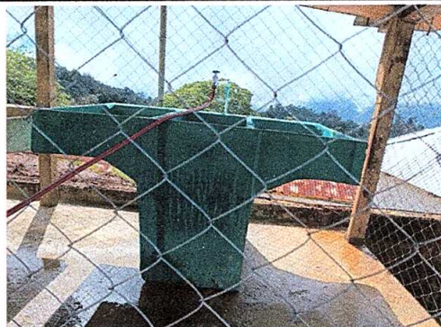
Foto 4: Sustitución de pila de cocina de dos lavaderos.
