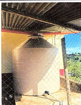
Foto 5: Sustitución de depósitos de agua.
