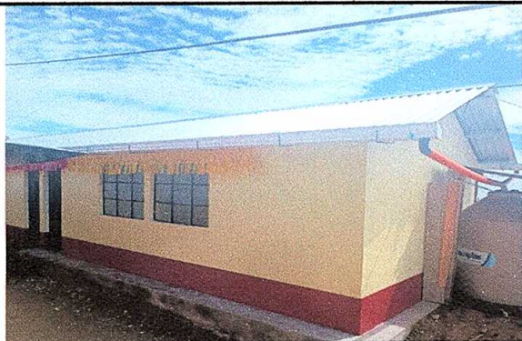
Foto 1: Se observa la sustitución completa de la cubierta de lámina del Módulo III de aulas.
