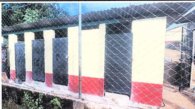
Foto 3: Sustitución de metal en servicios sanitarios.
