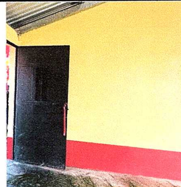
Foto 2: Reparación y mantenimiento de estructura a puertas de metal.
