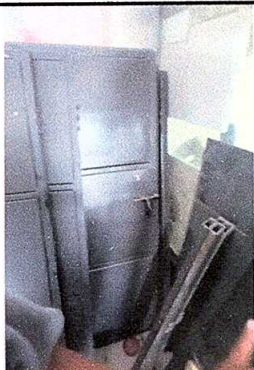
Foto 3: Avance del trabajo de sustitución de puertas de metal de baños.
