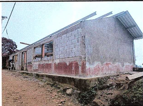
Foto 1: Se observa el avance del trabajo de sustitución de estructura de techo del Módulo III de aulas.
