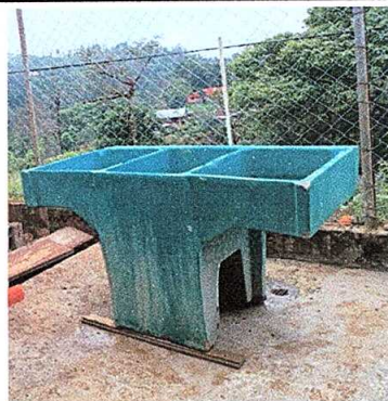
Foto 4: Avance de la colocación de pila.
