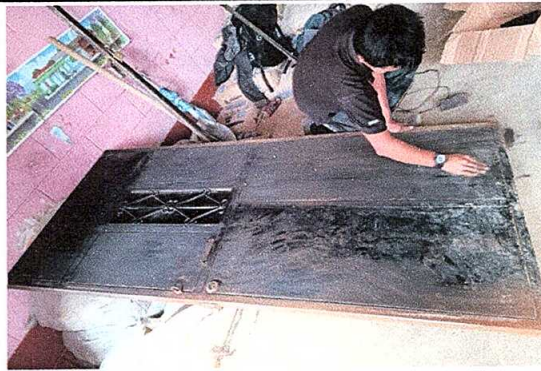
Foto 2: Mantenimiento a puertas del Módulo III de aulas.
