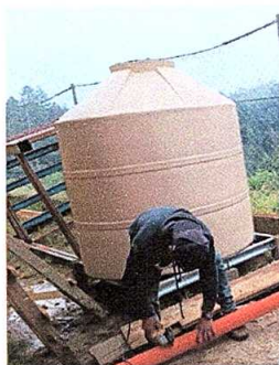
Foto 5: Trabajo de colocación de depósito de agua.
