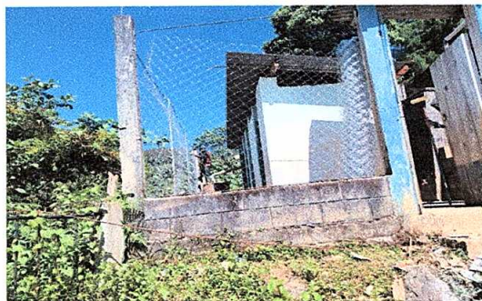
Foto 6: Colocación de malla.
