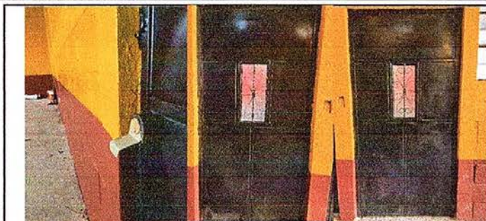
Foto7: Sustitución de 3 puertas de metal
