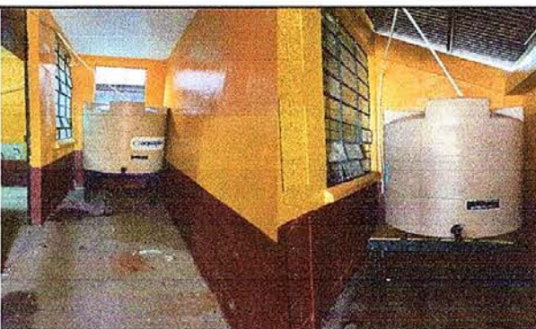
Foto 6: Sustrucción de depósito de agua, tinaco de 1700 litros
