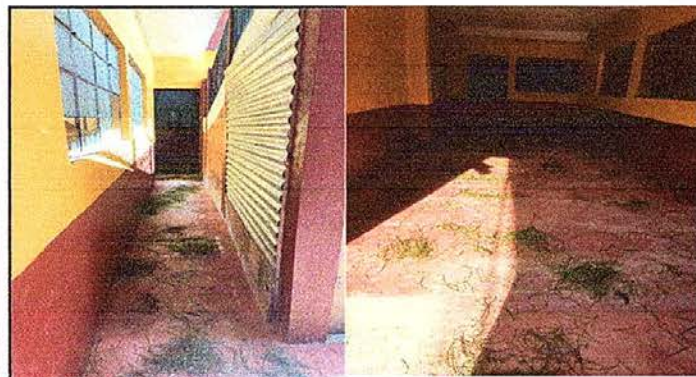
Foto 3: Sustrucción de piso de torta de concreto
