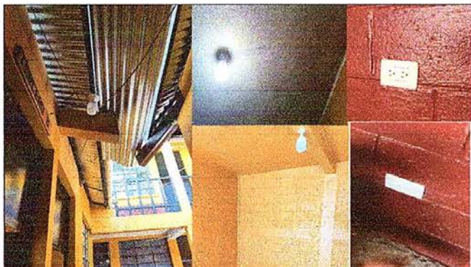
Foto 9: Sustitución de lámparas 2 x 40 por focos ahorradores, de plafoneras y de tomacorrientes dobles
