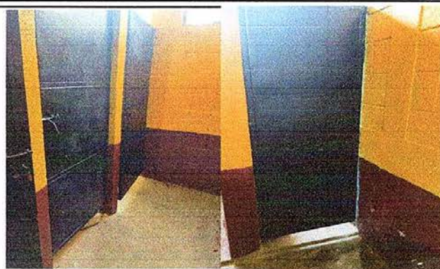
Foto 2: Sustrucción de puestas de madera de los sanitarios por puertas de metal (1.60m x 0.70m)
