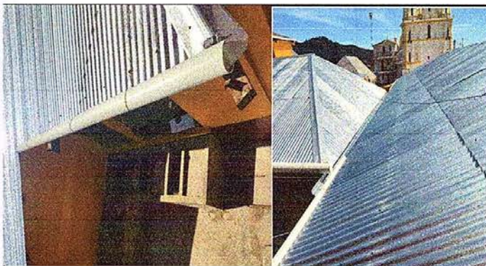
Foto 4: Sustrucción de canales de metal y bajadas de agua pluvial de tubo PVC de 3"
