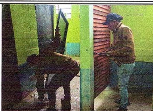
Foto 2: Sustitución de puertas de madera de los sanitarios por puertas de metal (1.60m x 0.70m)
