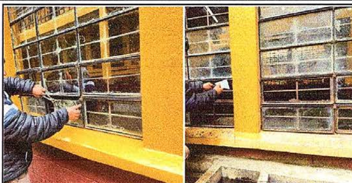
Foto 8: Sustitución de vidrios de ventanas de metal
