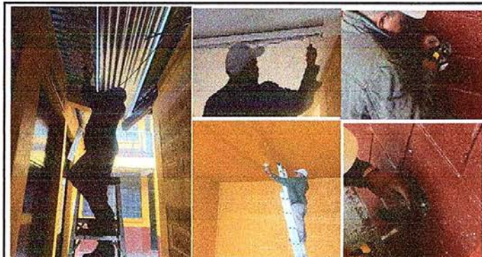
Foto 9: Sustitución de lámparas 2 x 40 por focos ahorradores, de plafoneras y de tomacorrientes dobles
