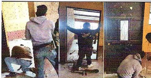
Foto7: Sustitución de 3 puestas de metal
