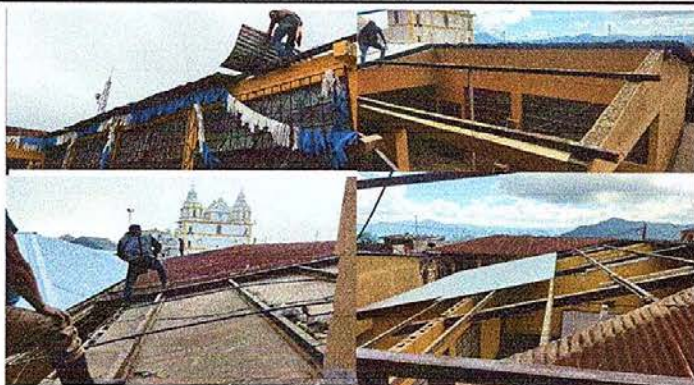
Foto1: Sustitución de Lámina en malas condiciones
