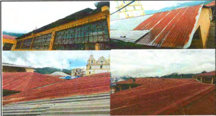
Foto1: Sustitución de Lámina en malas condiciones
