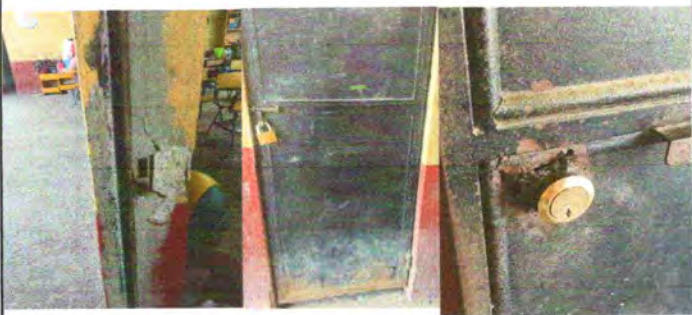
Foto7: Sustitución de 3 puestas de metal
