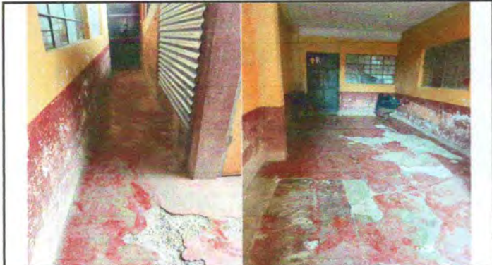
Foto 3: Sustitución de piso de torta de concreto
