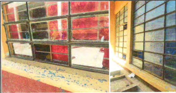
Foto 8: Sustitución de vidrios de ventanas de metal
