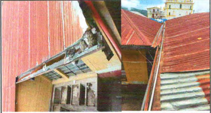
Foto 4: Sustitución de canales de metal y bajadas de agua pluvial de tubo PVC de 3"
