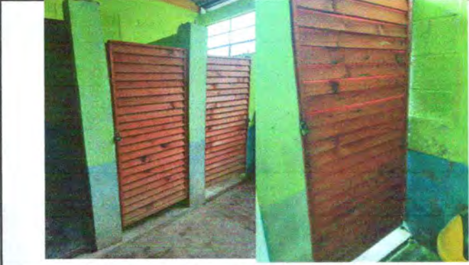
Foto 2: Sustitución de puestas de madera de los sanitarios por puertas de metal (1.60m x 0.70m)
