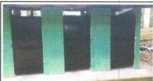
FOTO 5 CAMBIO DE 3 PUERTAS DE MADERA POR METAL
