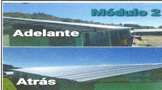
FOTO 2 SUSTITUCIÓN DE LÁMINA MÓDULO 2
