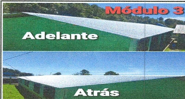
FOTO 3 SUSTITUCIÓN DE LÁMINA MÓDULO 3
