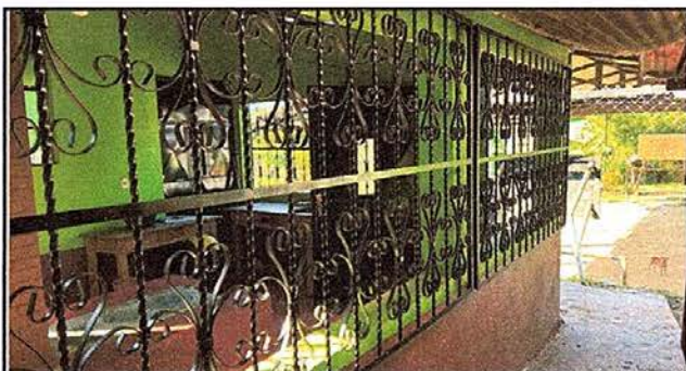
Foto 12: Sustitución de balcones de metal 1.20 x 185 metros.
