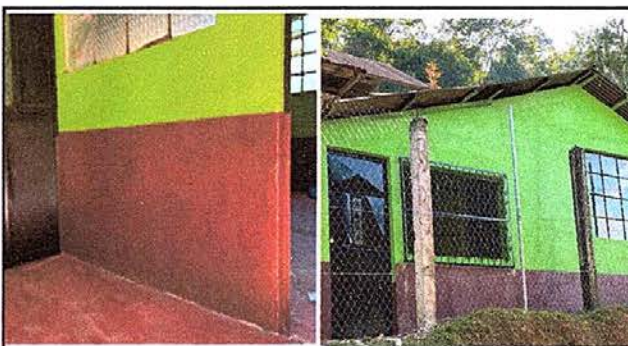
Foto 4: Pintura en muros exteriores e interiores.
