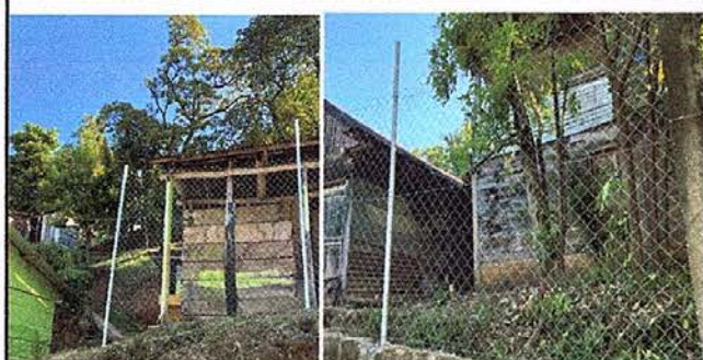
Foto 7: Reparación de tubo hg y malla galvanizada.
