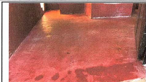
Foto 1: Mejoramiento de piso de concreto en cocina.
