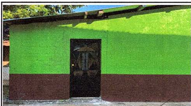
Foto 10: Sustitución de puerta de madera.
