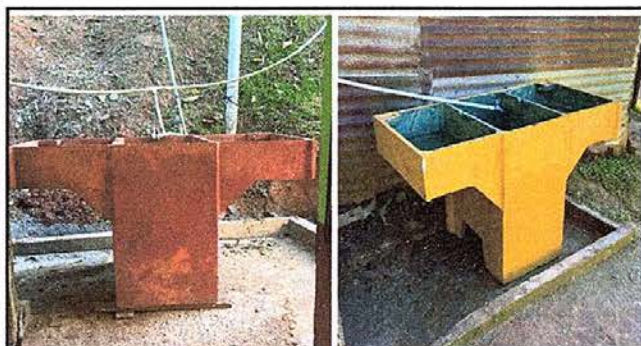
Foto 3: Sustitución de lavamano de concreto por pila y sustitución de pila de concreto de dos lavadero.
