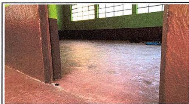
Foto 5: Reparación de piso de torta de concreto en aulas.
