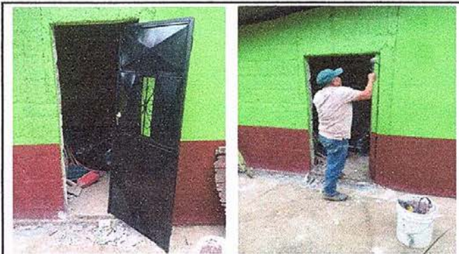
Foto 10: Sustitución de puerta de madera por metal.
