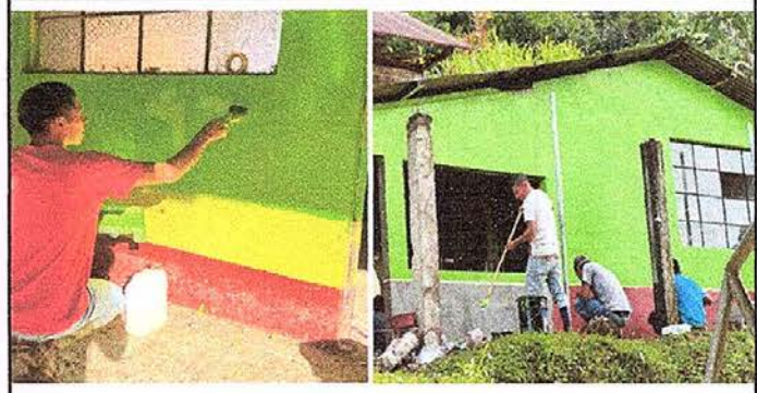
Foto 4: Pintura en muros exteriores e interiores.
