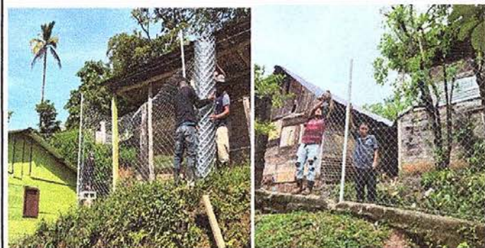
Foto 7: Reparación de tubo hg y malla galvanizada.
