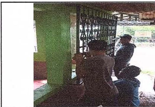
Foto 12: Sustitución de balcones de metal 1.20 x 1.85 metros.
