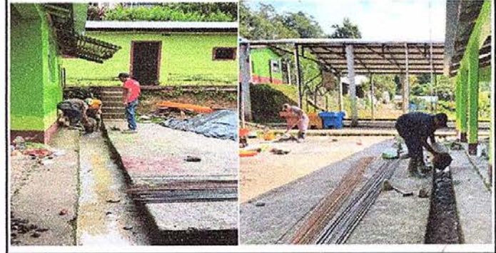
Foto 6: Reparación de cuneta de concreto.
