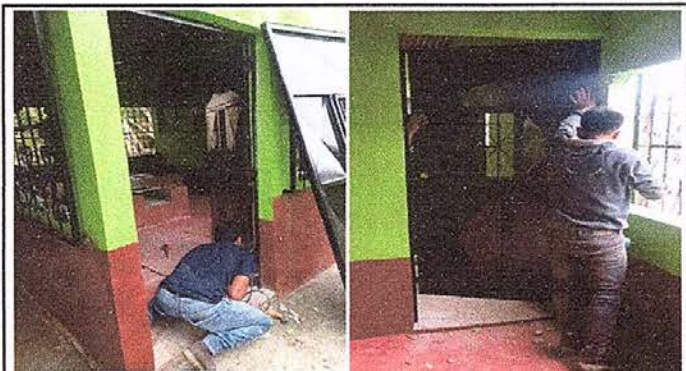
Foto 8: Sustitución de puerta de madera por metal y puerta de metal por metal en cocina.
