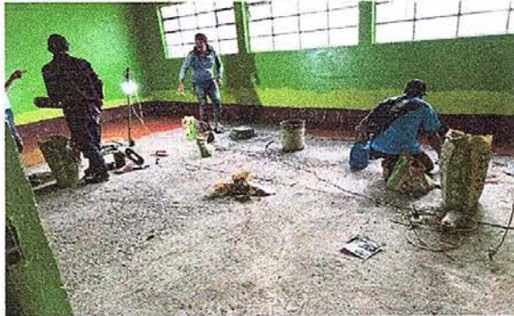
Foto 5: Reparación de piso de torta de concreto en aulas.
