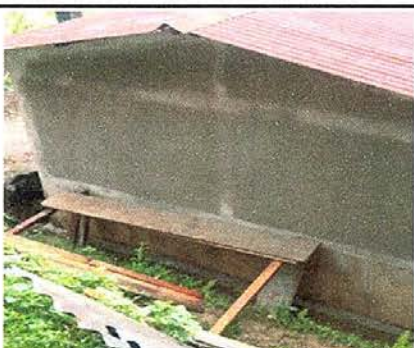
Foto 13: Repello de pared en cocina.
