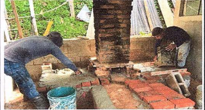
Foto 2: Sustitución de plancha artesanal completa.
