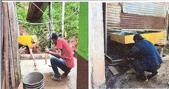
Foto 3: Sustitución de lavamano de concreto por pila y sustitución de pila de concreto de dos lavadero.
