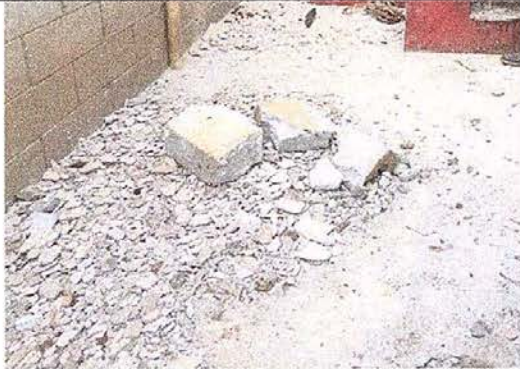
Foto 1: Mejoramiento de piso de concreto en cocina.
