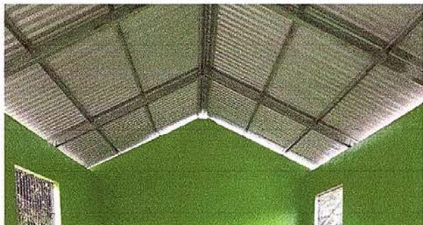
Foto 13: Sustitución de soporte de madera por metal.
