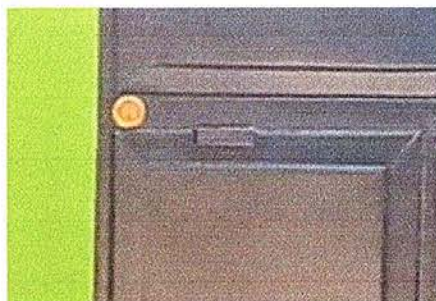
Foto9: sustitución de chapas en puerta de metal
