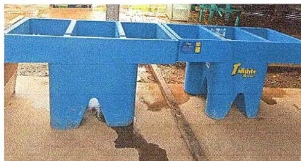
Foto10: Sustitución de pila plástica de dos lavaderos
