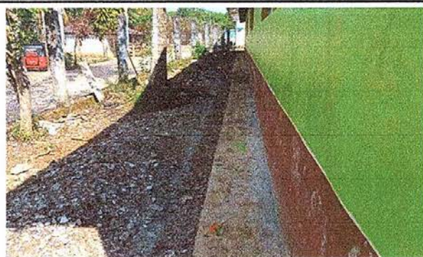
Foto8: Reparación de banquetas de concreto
