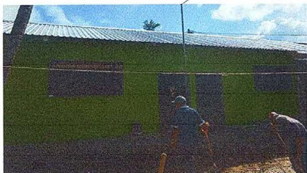
Foto1: Sustrucción de pared de madera por bloék
