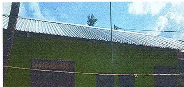
Foto 2: Sustrucción de lámina, por lámina troquelada calibre 26
