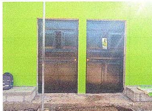
Foto 4: Sustrucción de puerta de madera por metal de 2.10mtrs de alto y 1.10 de ancho
