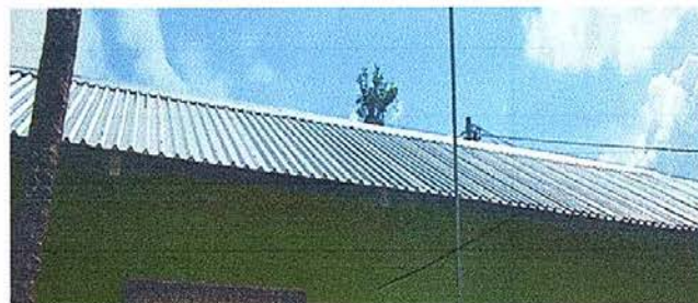
Foto 6: Sustrucción capote de lámina para lámina troquelada.
