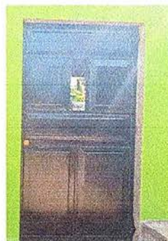
Foto12: Mantenimiento a estructura de puerta 2.10 * 1.10
