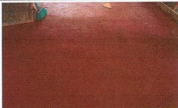
Foto 5: Sustrucción de piso de concreto
