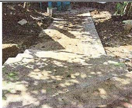
Foto11: Reparación de cuneta de concreto
