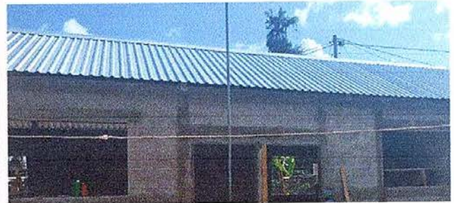
Foto 6: Sustitución capote de lámina para lámina troquelada.
