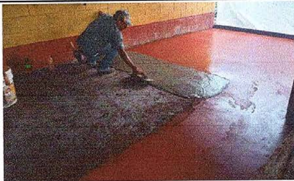
Foto 5: Sustitución de piso de concreto
