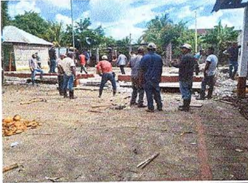
Foto1: Sustitución de pared de madera por block
