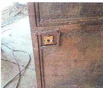
Foto9: sustitución de chapas en puerta de metal
