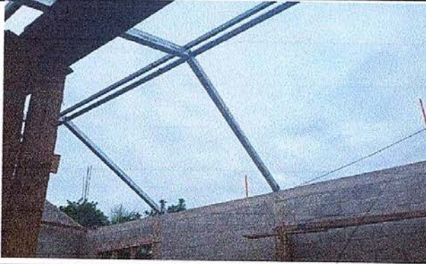
Foto 13: Sustitución de soporte de madera por metal.
