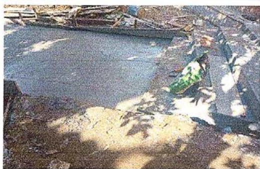
Foto11: Reparación de cuneta de concreto
