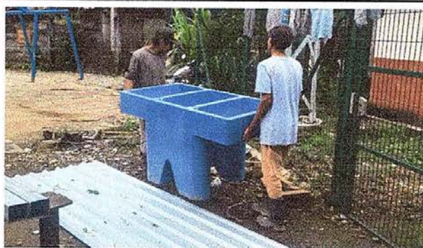
Foto10: Sustrucción de pila plástica de dos lavaderos
