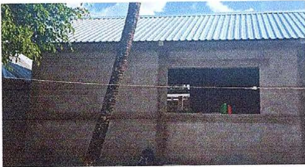
Foto 3: Mejoramiento de ventanas o balcones de hierro
