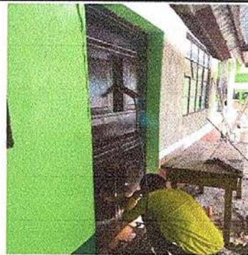
Foto12: Mantenimiento a estructura de puerta 2.10 * 1.10
