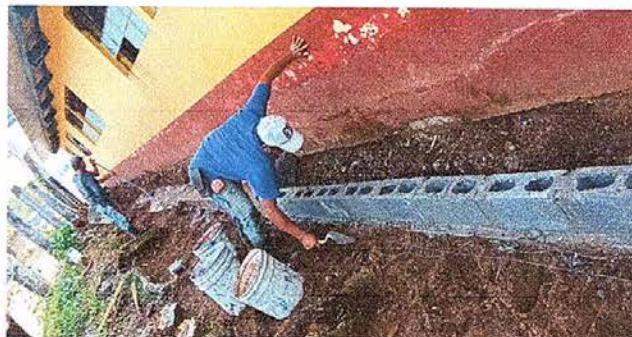
Foto8: Reparación de banquetas de concreto
