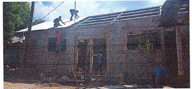
Foto 2: Sustitución de lámina, por lámina troquelada calibre 26
