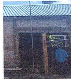
Foto 4: Sustitución de puerta de madera por metal de 2.10mts de alto y 1.10 de ancho
