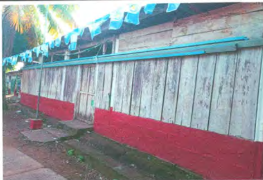
Foto1: Sustrucción de pared de madera por block
