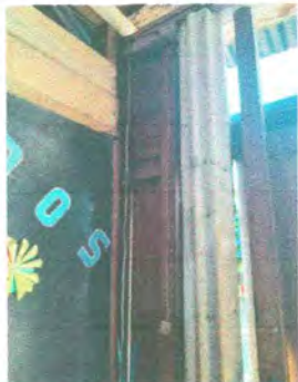
Foto7: Sustrucción del ducto electrico y sus accesorios
