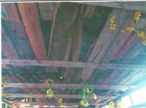
Foto13: Sustitución de soporte de madera por metal.
