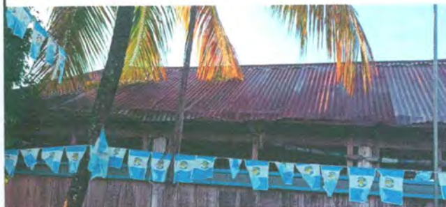
Foto 2: Sustrucción de lámina, por lámina troquelada calibre 26
