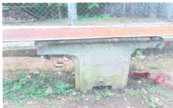
Foto10: Sustrucción de pila plástica de dos lavaderos
