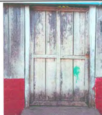
Foto 4: Sustrucción de puerta de madera por metal de 2.10mts de alto y 1.10 de ancho
