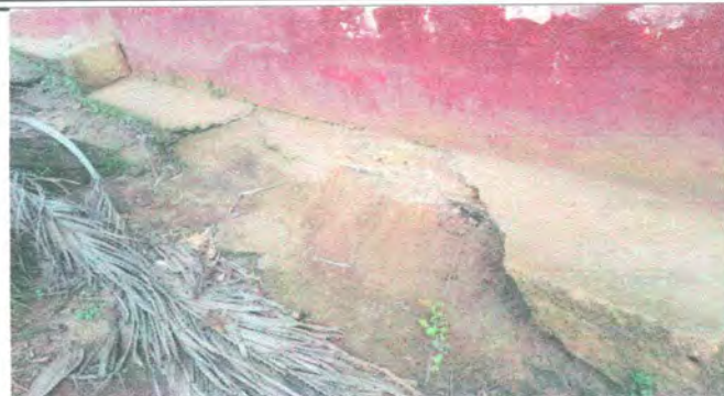
Foto8: Reparación de banquetas de concreto
