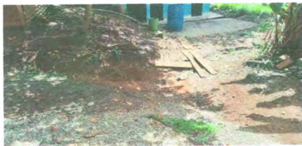
Foto11: Reparación de cuneta de concreto
