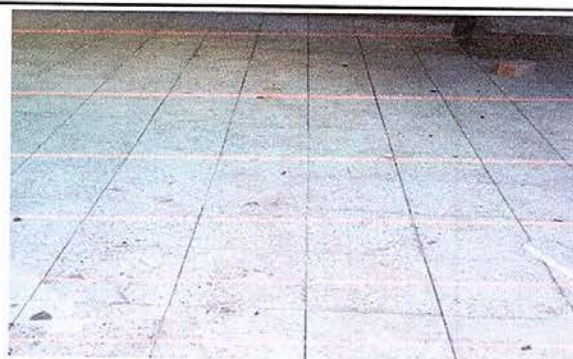
Foto 12: Sustitución de piso de concreto por piso de granito.
