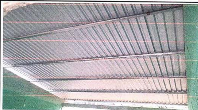
Foto 4: Cambio de costaneras de dos aulas con las siguientes medidas: 11 mts de ancho y 13 mts de largo en su totalidad.
