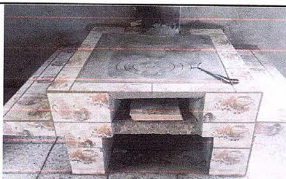
Foto 11: Sustitución de plancha de metal e instalación de azulejos.
