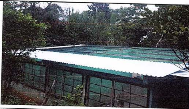
Foto 3: Cambio de costaneras de dos aulas con las siguientes medidas 11 Mts de ancho y 13 Mts de largo en su totalidad.
