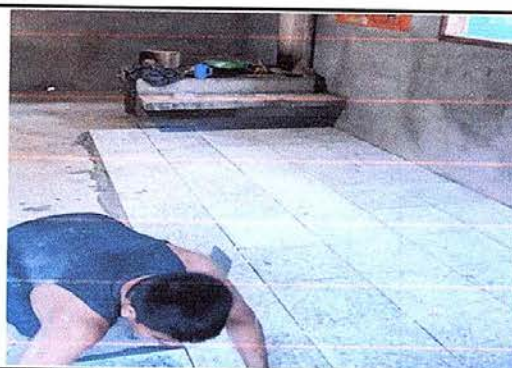
Foto 12: Sustitución de piso de concreto por piso de granito.
