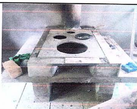
Foto 11: Sustitución de plancha de metal e instalación de azulejos.
