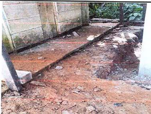
Foto 9: Reparación de planchas de concreto.
