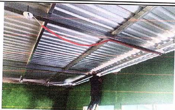
Foto 13: Sustitución del sistema eléctrico.
