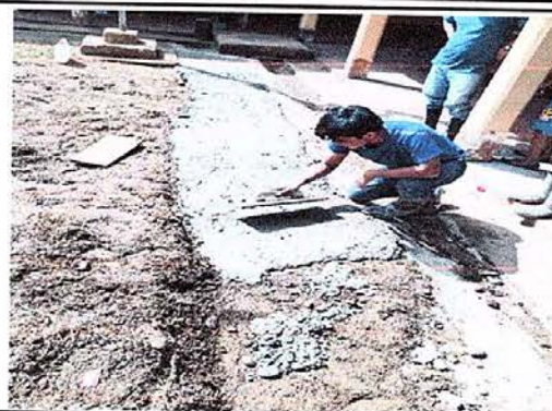
Foto 8: Reparación de cunetas de concreto.
