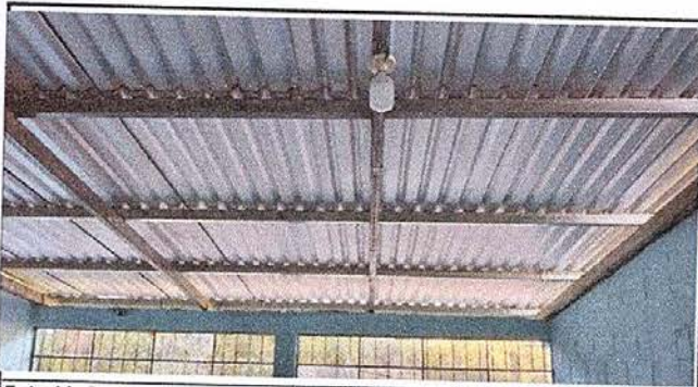
Foto 11: Sustitución de focos ahorradores
