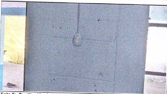
Foto 9: Sustitución de interruptores
