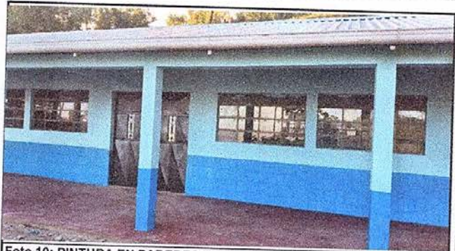
Foto 10: PINTURA EN PAREDES EXTERIORES E INTERIORES
