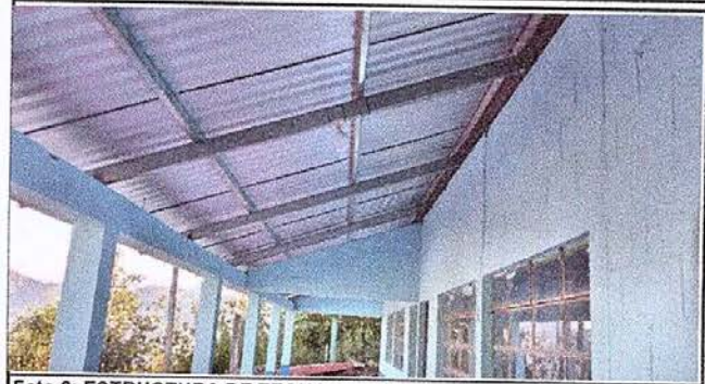
Foto 2: ESTRUCTURA DE TECHO. Sustitución de soporte de estructura de madera por metal
