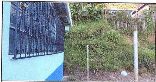
Foto 6: Mantenimiento a balcones de metal
