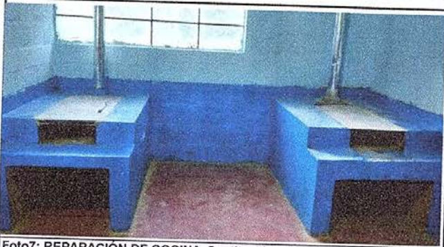
Foto 7: REPARACIÓN DE COCINA. Sustitución de planchas y tubos de chimenea.
