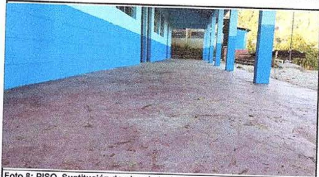
Foto 8: PISO. Sustitución de piso de torta de cemento para la cocina y tres aulas.
