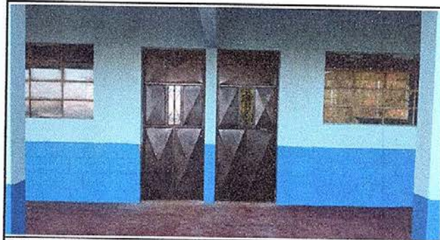
Foto 4: PUERTAS DE METAL. Sustitución de puertas de 2.15 X 98 M2 C/U (tres puertas para 3 aulas y una para la cocina)
