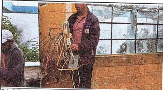
Foto 9: Sustrucción de interruptores
