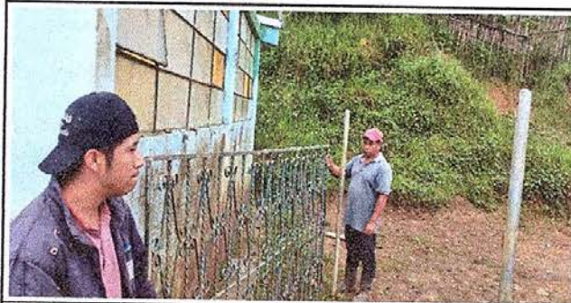
Foto 6: Mantenimiento a balcones de metal
