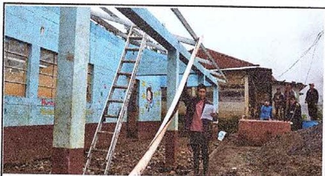
Foto 3: CANALES DE AGUA PLUVIAL. Sustitución de canales de pvc
