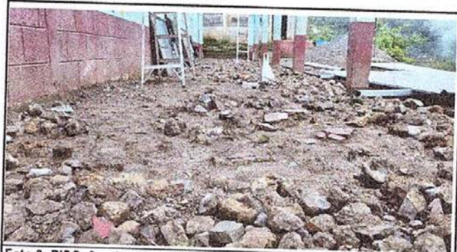
Foto 8: PISO. Sustrucción de piso de torta de cemento para la cocina y tres aulas.
