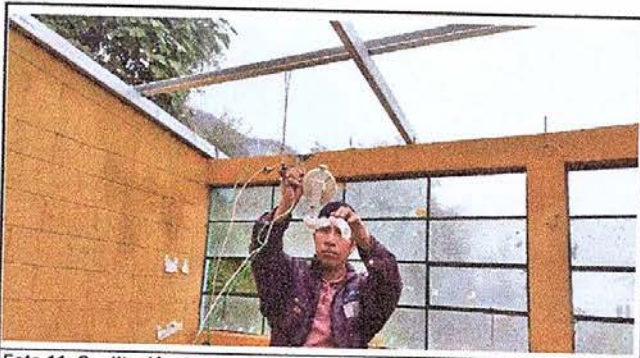
Foto 11: Sustrucción de focos ahorradores
