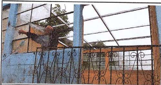
Foto 5: VENTANAS. Sustitución de vidrios de 53x29 centímetro cada vidrio
