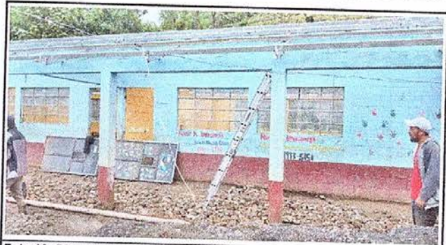
Foto 10: PINTURA EN PAREDES EXTERIORES E INTERIORES
