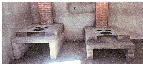
Foto 6: REPARACIÓN DE COCINA: SUSTITUCION COMPLETA DE ESTUFA RURAL
