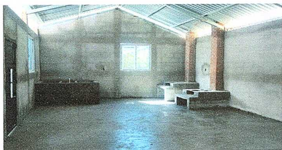
Foto 9: SUSTITUCIÓN DE PISO
