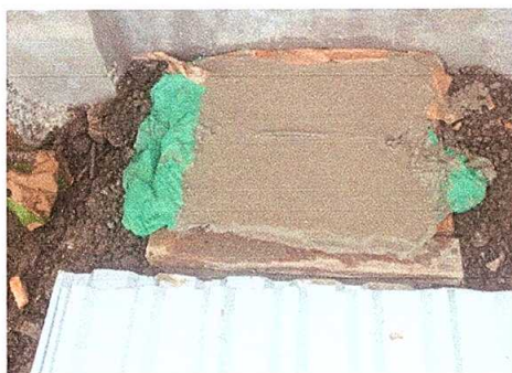
Foto 5: DRENAJE. SUSTITUCIÓN DE CAJA DE REGISTRO
