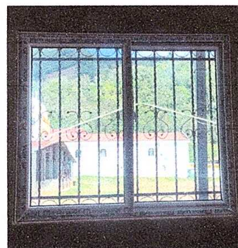
Foto 4: SUSTITUCIÓN DE VENTANAS
