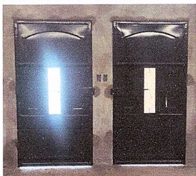
Foto 3: SUSTITUCION DE PUERTAS
