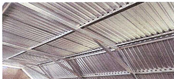
Foto 2: ESTRUCTURA DE TECHO
