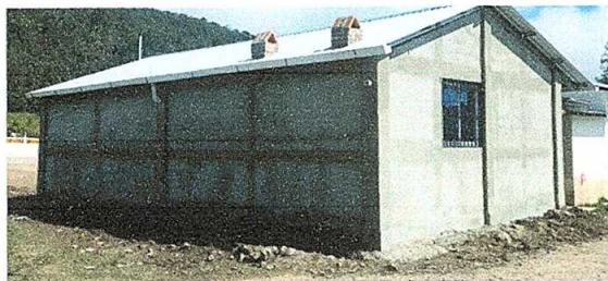
Foto 7: SUSTITUCIÓN DE PARED DE COCINA MADERA POR BLOCK
