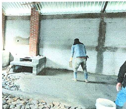
Foto 9: SUSTITUCIÓN DE PISO
