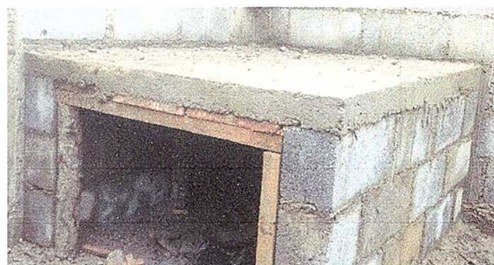
Foto 6: REPARACIÓN DE COCINA: SUSTITUCION COMPLETA DE ESTUFA RURAL
