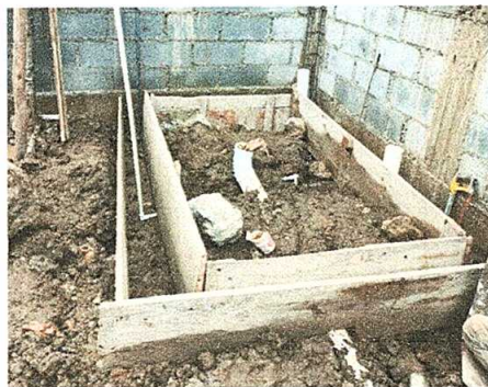
Foto 8: REPARACIÓN DE COCINA: PILA DE CEMENTO DE DOS LAVADEROS
