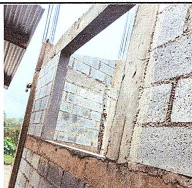
Foto 4: SUSTITUCIÓN DE VENTANAS
