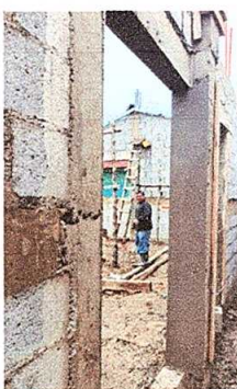
Foto 3: SUSTITUCION DE PUERTAS
