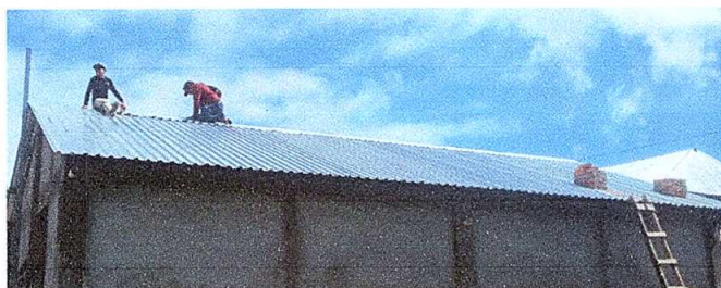
Foto 1: CUBIERTA DE LÁMINA
