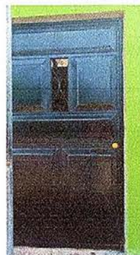
Foto 4: Sustitución de puerta de madera por metal de 2.10mts de alto y 1.10 de ancho
