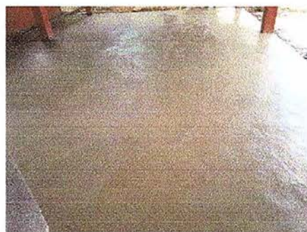
Foto10: Reparación de plancha de concreto de patio
