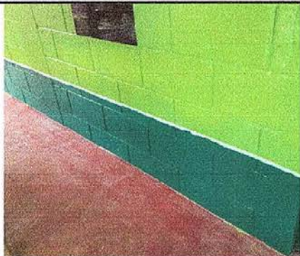
Foto11: Pintura en muros exteriores e interiores
