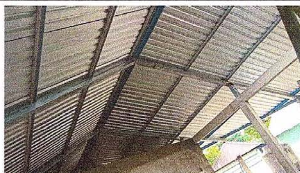
Foto8: Sustitución de soporte de madera por metal.
