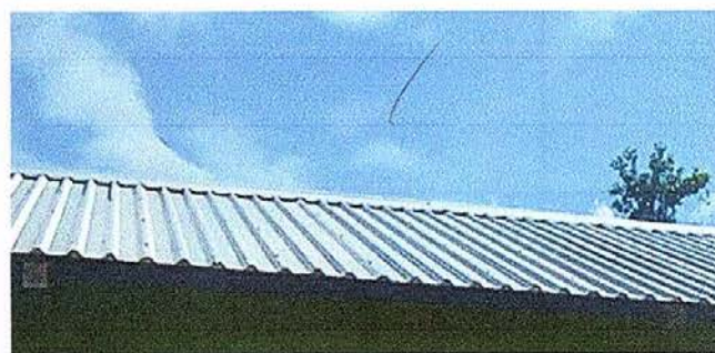
Foto 6: Sustitución de capote de lámina para lámina troquelada.
