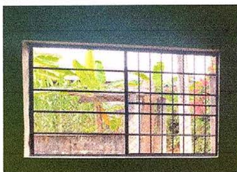
Foto 3: Mejoramiento de ventanas de hierro
