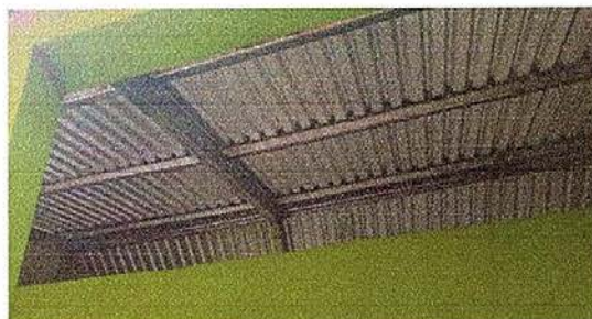
Foto 2: Sustitución de lámina, por lámina troquelada calibre 26
