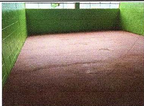
Foto 5: Sustitución de piso de concreto
