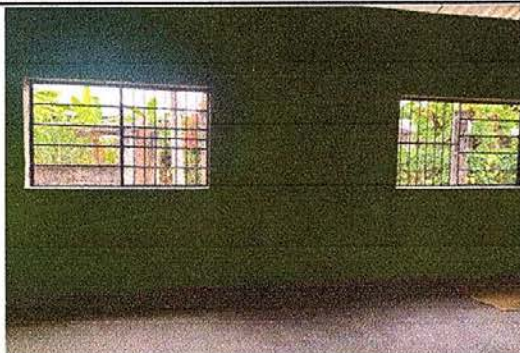
Foto 1: Sustitución de pared de madera por block
