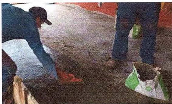
Foto 5: Sustitución de piso de concreto
