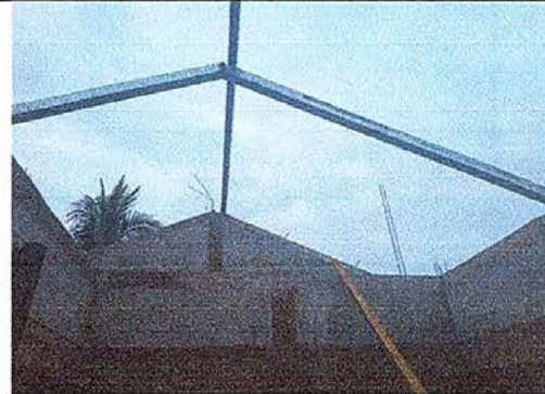
Foto8: Sustitución de soporte de madera por metal.
