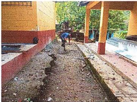
Foto9: Reparación de cuneta de concreto
