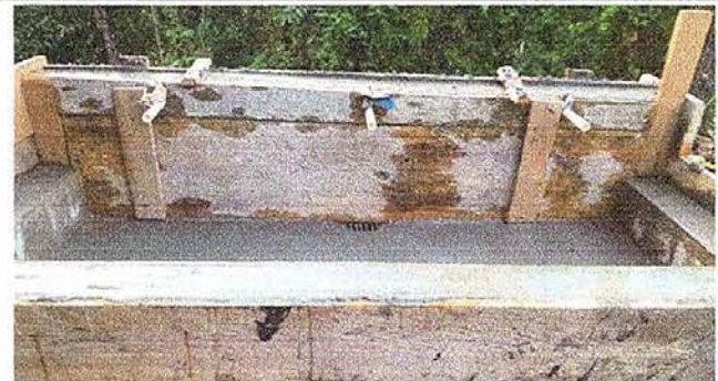
Foto12: Sustitución de lavamanos
