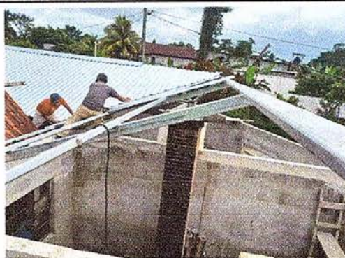
Foto 2: Sustitución de lámina, por lámina troquelada calibre 26
