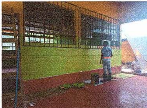
Foto11: Pintura en muros exteriores e interiores
