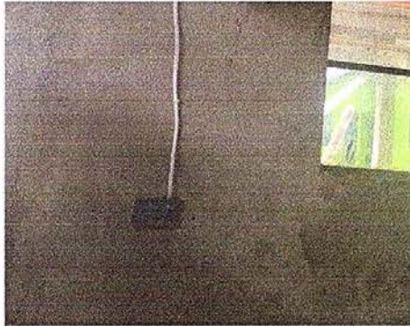
Foto7: Sustitución del ducto electrico y sus accesorios
