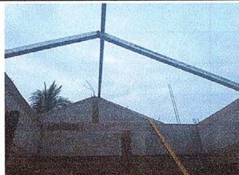
Foto 6: Sustitución de capote de lámina para lámina troquelada
