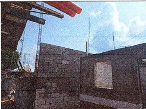
Foto1: Sustitución de pared de madera por block
