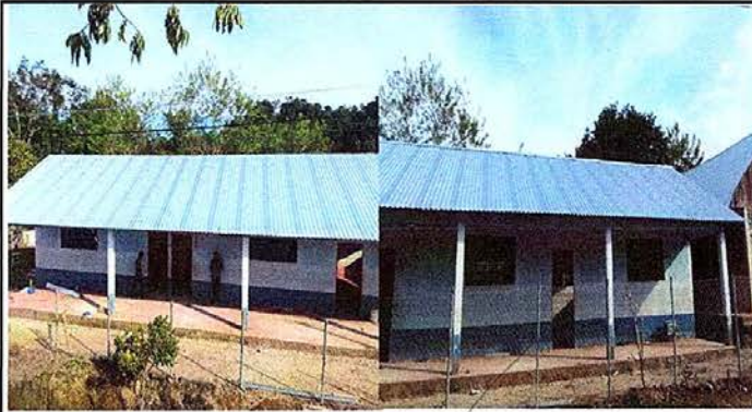
Foto 1: Sustitución de láminas, por lámina troquelada calibre 26.
