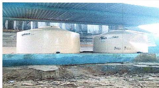
Foto 8: Sustitución de depósito de agua.
