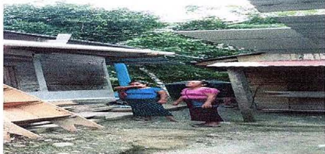
Foto 9: Sustitución de canales de PVC.
