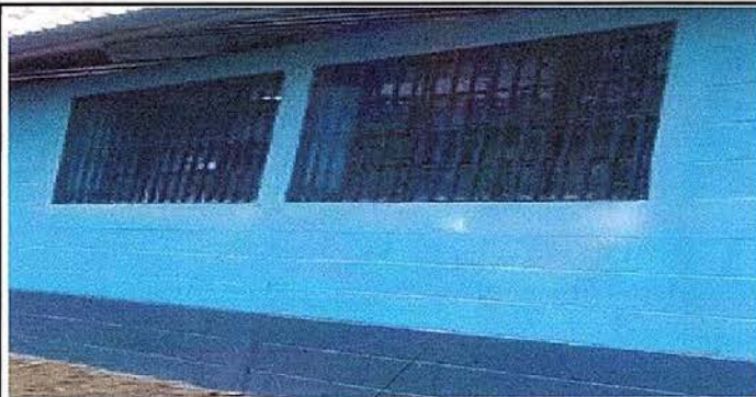
Foto 5: Balcones de metal.
