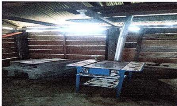
Foto 7: Sustitución de plancha de metal de 3 hornillas.
