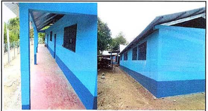
Foto 4: Pintura en muros exteriores e interiores.
