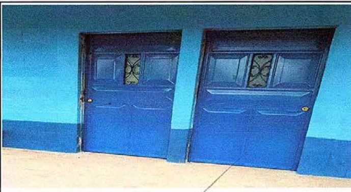
Foto 3: Sustitución de puertas.
