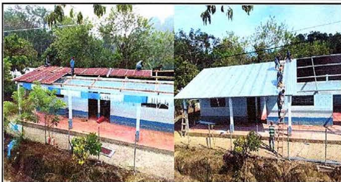
Foto 1: Sustitución de láminas, por lámina troquelada calibre 26.
