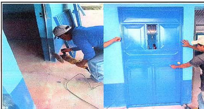
Foto 3: Sustitución de puertas.
