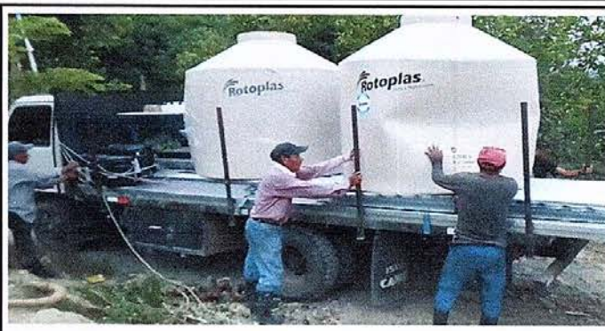
Foto 8: Sustitución de depósito de agua.
