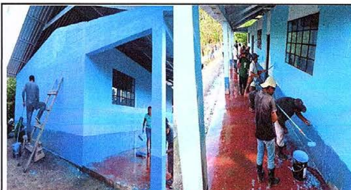
Foto 4: Pintura en muros exteriores e interiores.
