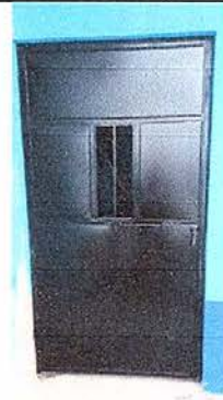
Foto No. 4: Sustitución de puerta de madera por metal de 2.10 x 1.09 mts.
