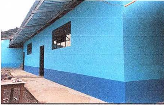
Foto No. 1: Sustitución de madera por block
