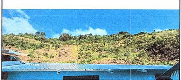
Foto No. 2: Sustitución de lámina en malas condiciones
