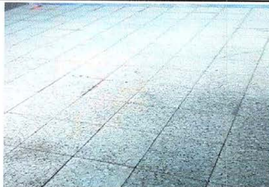
Foto No. 8: Reparación de piso de granito.
