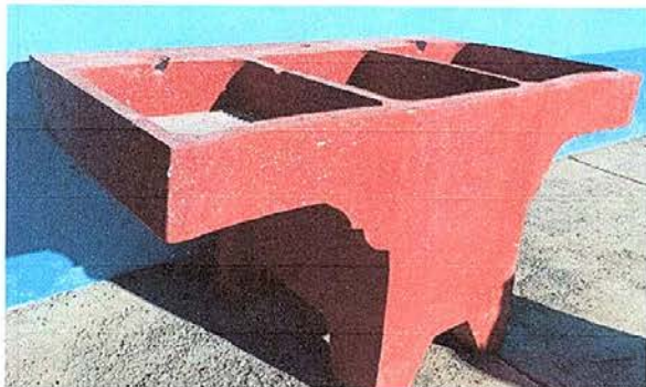
Foto No. 7: Sustitución de pila de dos lavaderos y mejoramiento de torta de concreto.
