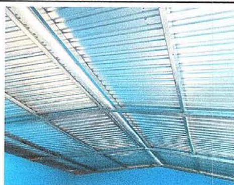
Foto No. 10: Sustitución de estructura de madera por metal.
