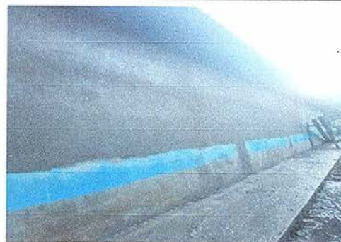
Foto No. 6: Aplicación de pintura en muros exteriores e interiores.
