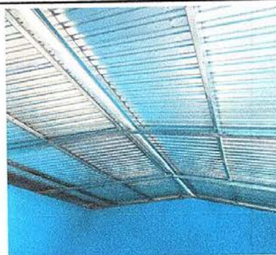
Foto No. 10: Sustrucción de estructura de madera por metal.
