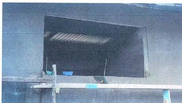
Foto No. 3: Sustrucción de ventana de madera por metal más vidrio.
