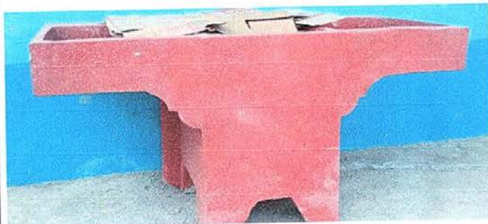
Foto No. 7: Sustrucción de pila de dos lavaderos y mejoramiento de torta de concreto.
