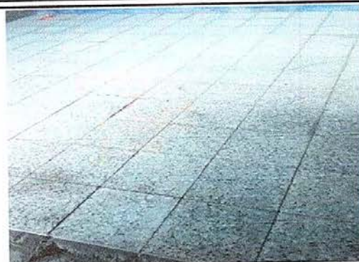
Foto No. 8: Reparación de piso de granito.
