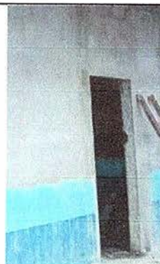
Foto No. 4: Sustrucción de puerta de madera por metal de 2.10 x 1.09 mts.
